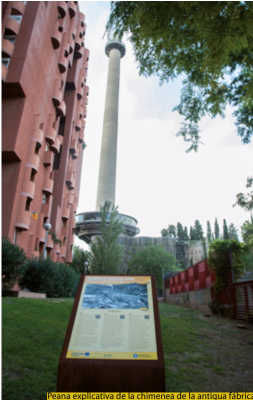
Peana explicativa de la chimenea de la antigua fábrica Sanson / Ayuntamiento de Sant Just Desvern
